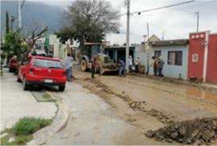
Se realizan estudios para rehabilitación del pavimento.
